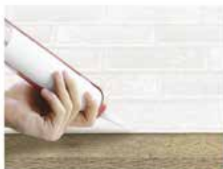
Нанесите клей на края и ребра панели
