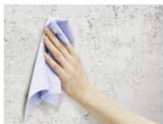
Очистите поверхность от пыли
